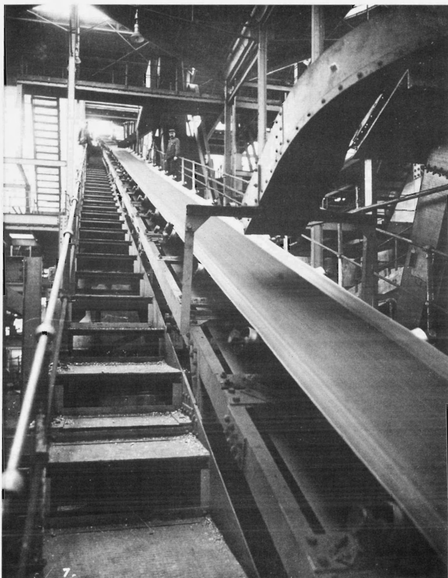
Transporteur des 0/85 bruts vers le lavoir / Transportband voor de gesorteerde steenkolen (0/85) naar de wasserij. In de zeveryj werden de kolen gescheiden in stukkolen en gruis. De stukkolen gingen over een lopende band direct naar de wagons. Onderweg werden steenbrokken eruit gelezen en op een ijzeren band naar buiten afgevoerd. Het grove kolengruis wordt door een gummiband van 64 meter lengte en een meter breedte naar de wasserij getransporteerd.
