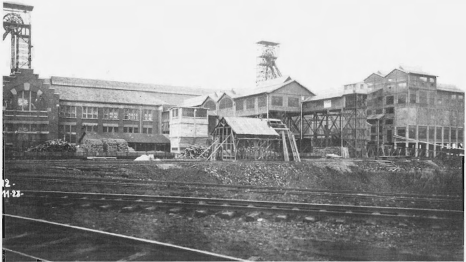
Vue générale de l'installation/ Overzicht van het gebouwencomplex met op de achtergrond de twee 55 meter hoog oprijzende schachtbokken en op de voorgrond spoorrails. De rangeersporen, die in een driehoek waren aangelegd, maakten over het gehele terrein het éénrichtingsverkeer mogelijk. De beide schachten mondden uit in het 146 meter lange schachtgebouw. Hier hoorde men dagelijks het wisselen van de signalen tussen de arbeiders op de laadplaatsen ondergronds en de machinisten van de ophaalmachines bovengronds.
