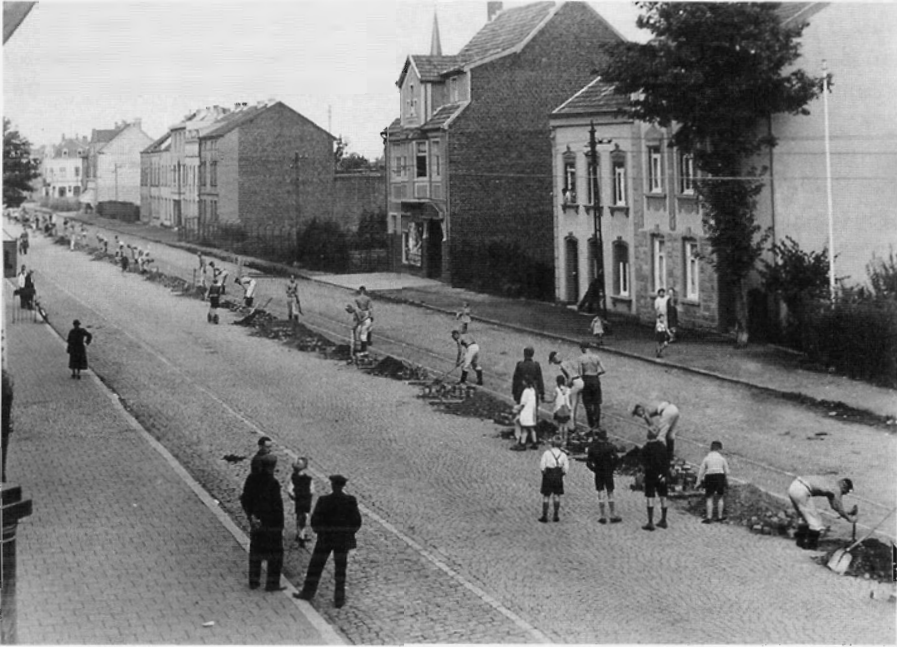
Nieuwstraat, graafwerkzaamheden ten behoeve van de grensafscheiding, 1939. Foto, collectie Gemeentearchief Kerkrade.
