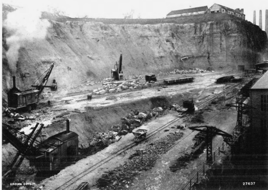
Stoomaangedreven lepelbaggers graven zich door de wand van de Sint Pietersberg, ca. 1929. Uit: ENCI 60 jaar jong 1926-1986. Extra editie ENCI-Schakels, september 1986.
