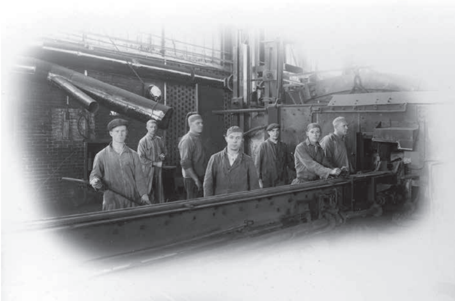
Aan de achterkant van de oven stonden de buizentrekkers gereed naast te trekband. Een ketting trok de roodgloeiende strippen uit de oven door een gietijzeren trechter waarin deze onder hoge druk werden rondgevouwen en gelast. Foto: 1937.
