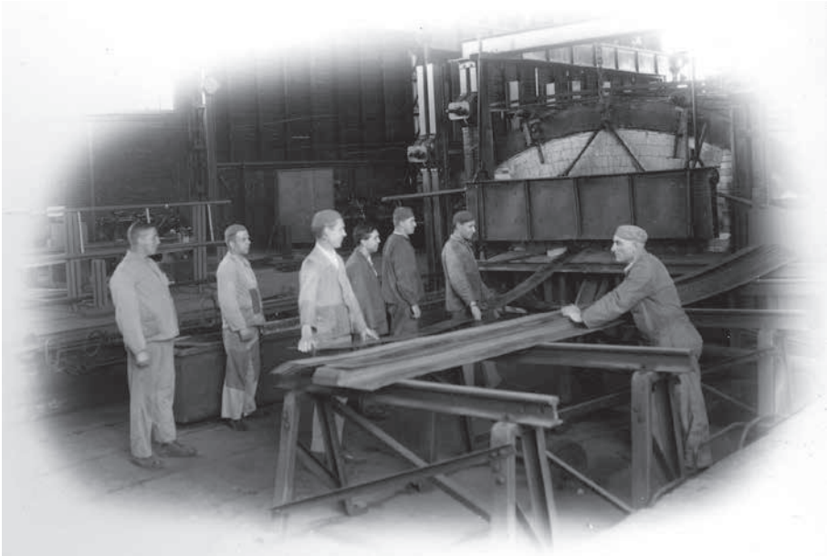
De oven stond centraal in het productieproces. Aan de voorkant bevonden zich de ovenladers, die ervoor zorgden dat de oven steeds weer werd gevoed met nieuwe stalen strippen. Foto: 1937.
