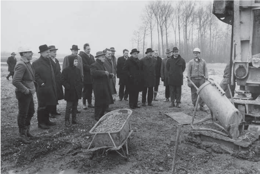
Het heien van de eerste paal voor de nieuwe fabriek van Staalwerken 'De Maas' aan de Beatrixhaven in Maastricht, in het bijzijn van de president-commissaris, de directie en leden van het bouwteam, 19 februari 1964.
