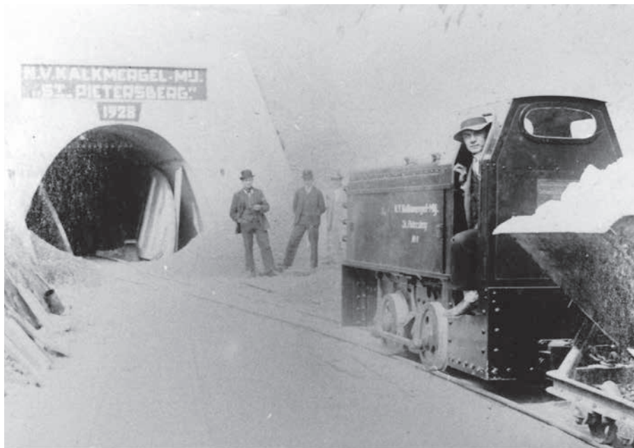
Ingang van de tunnel, de aanleg van de tunnel is hier al behoorlijk gevorderd. Er is al een spoor te zien, met een dieseltreintje erop dat wagonnetjes met mergel vervoert. Collectie Jan Spee.
