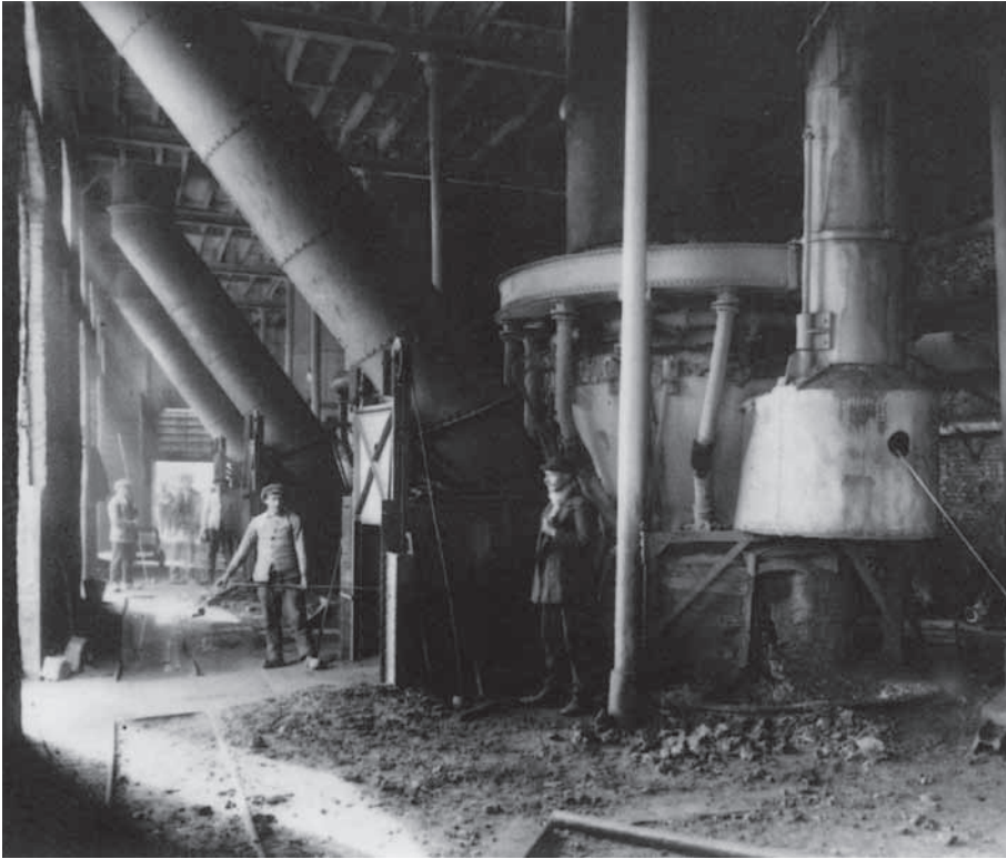
De loodovens van de in 1888 door de Duitse familie Schulte opgerichte metaalfabriek in Overpelt, 1930. Uit: De Koolputters. Geschiedenis van de Limburgse mijnwerkers 2, Voorgeschiedenis en pioniers (Zwolle 2005).
