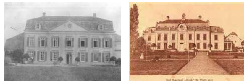
Afb. 13 a en b: Links: Kasteel Vliek sinds de achttiende-eeuwse verbouwing / herbouw in neoclassicistische stijl. Rechts: het herenhuis na de verbouwing van 1909. Het fronton boven de drie middelste vensters heeft plaatsgemaakt voor een ronde bekro-ning boven de entreepartij; twee dakvensters zijn vervangen door een zestal ramen, onderling verbonden door een balustrade; de hoekpaviljoens zijn hoger opgetrokken en (ook aan de zijde van het park) van vensters voorzien; rechts is een loggia aangebouwd [particuliere collectie]
