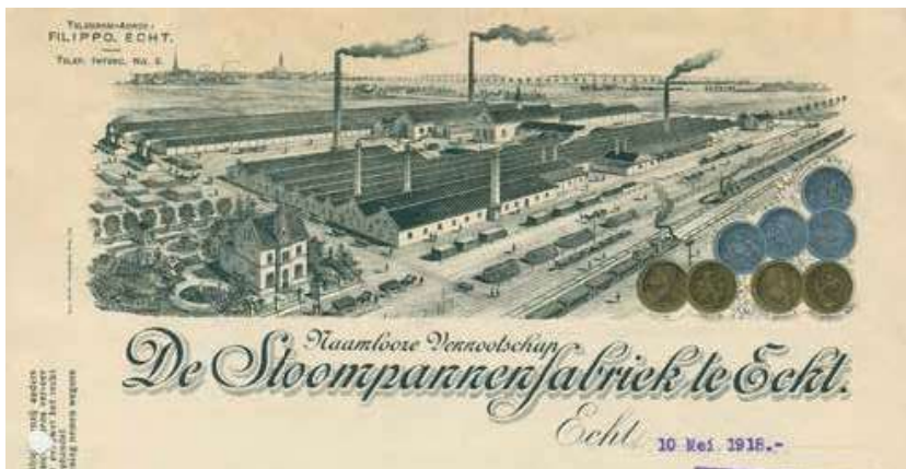
Afb. 18: De Stoompannenfabriek te Echt NV (1918) [Collectie HCL]
