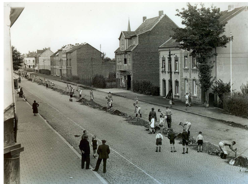
Aanleg prikkeldraadhek in de Nieuwstraat-Neustrasse in Kerkrade, oktober 1939 [Beeldbank Gemeente-archief Kerkrade, nr. 1888]
