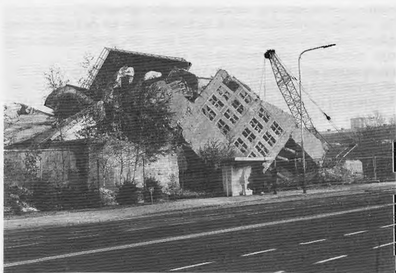
Het schachtgebouw van de Emma wordt neergehaald.
