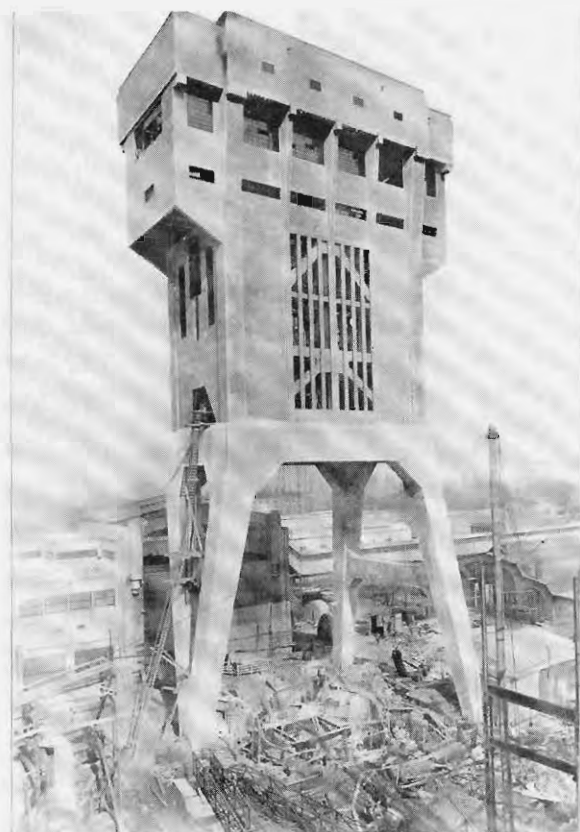
Fig. 10. Schachtbok van schacht 1 op staatsmijn Maurits. De opsluimachines van in het gebouw boven op den hak ondergebracht. De steunconstructie op den voortgrond is het begin van den toelooi en de kolentoren en staat thans aan het open graven van het gebouw op den achtergrond. Hoogte 56 M.
