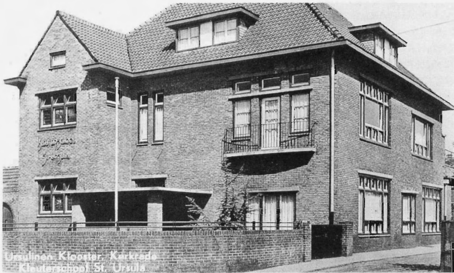
Het voormalige Ursulinenklooster, Holzstraat 19, Kerkrade, werd in 1967 deels als kantoor en magazijn in gebruik genomen (foto 1952, uit: R. Zwaak, Kerkrade in de jaren '50, 1991).
