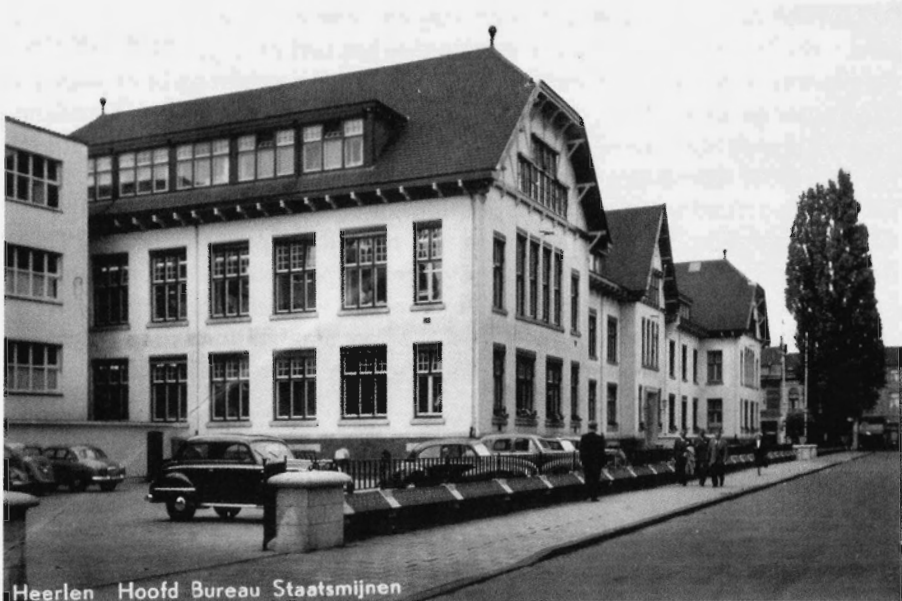
Hoofdgebouw Staatsmijnen in Heerlen, jaren veertig. SHCL, Doc. Nr. 30, fotocollectie.
