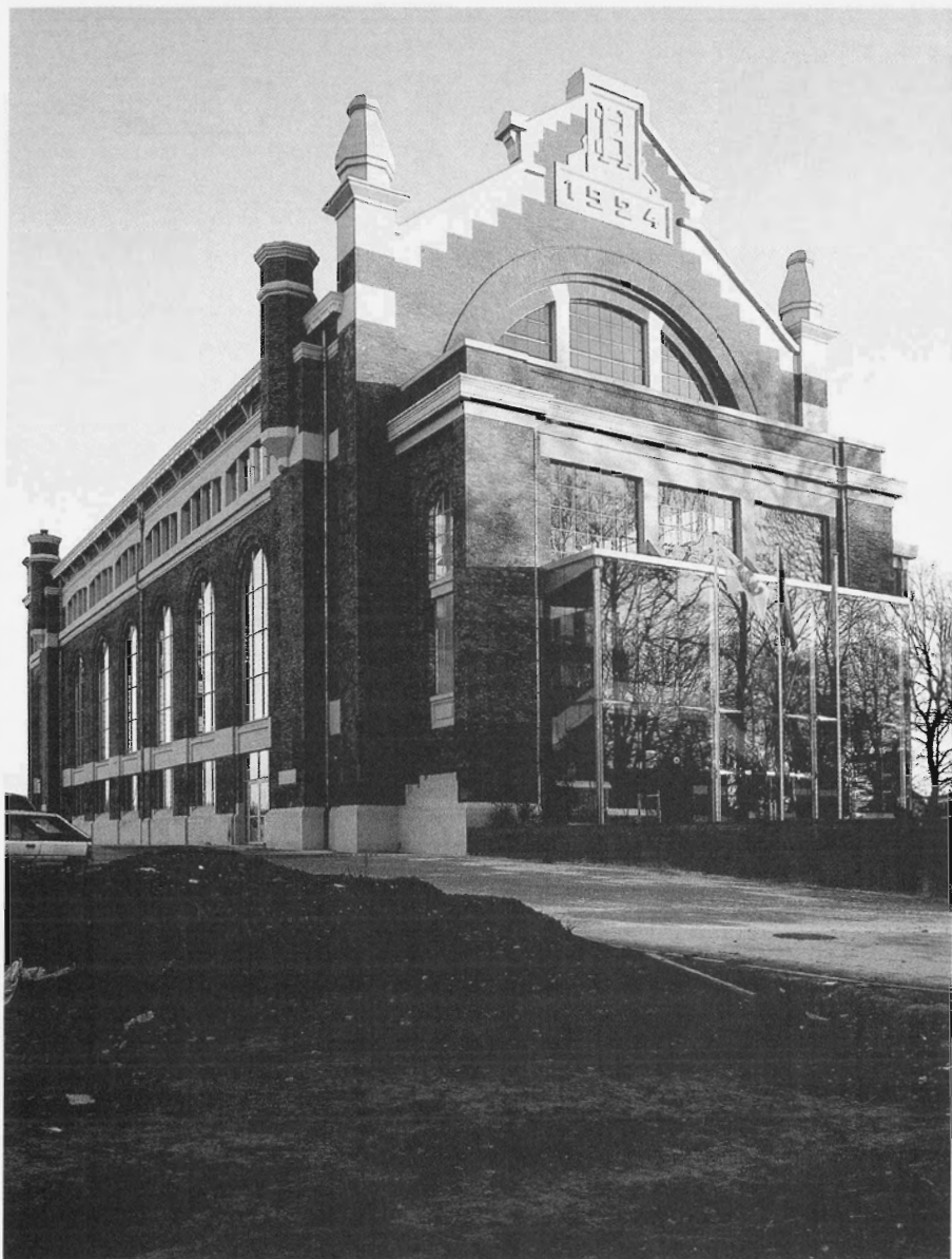
Zicht op de gerestaureerde en herbestemde voormalige elektrische centrale (1924) van Zolder die nog duidelijk in een prestigearchitectuur gebouwd werd. Na de brand van 1925 zal men goedkoper bouwen. Sinds december 2000 wordt het gebouw betrokken door het Europees Centrum voor Restauratietechnieken en wordt er geen elektriciteit maar vakkennis en vakkunde voor de sector van de bouw en de monumentenzorg geproduceerd. Foto PCCE: Bert Van Doorslaer.
