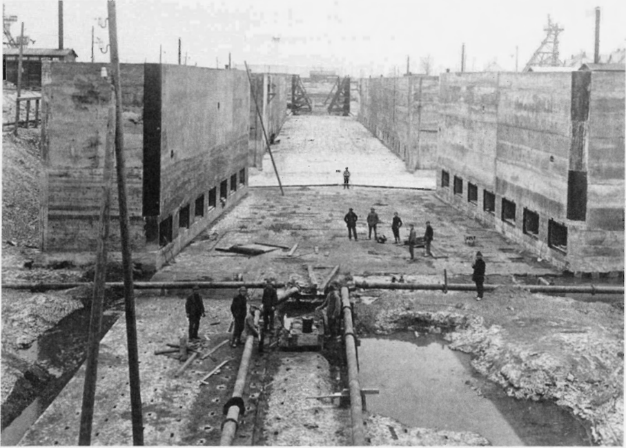
De schutkolk van de eerste sluis te Linne in aanbouw, 1920. Fotocollectie RHCL.
