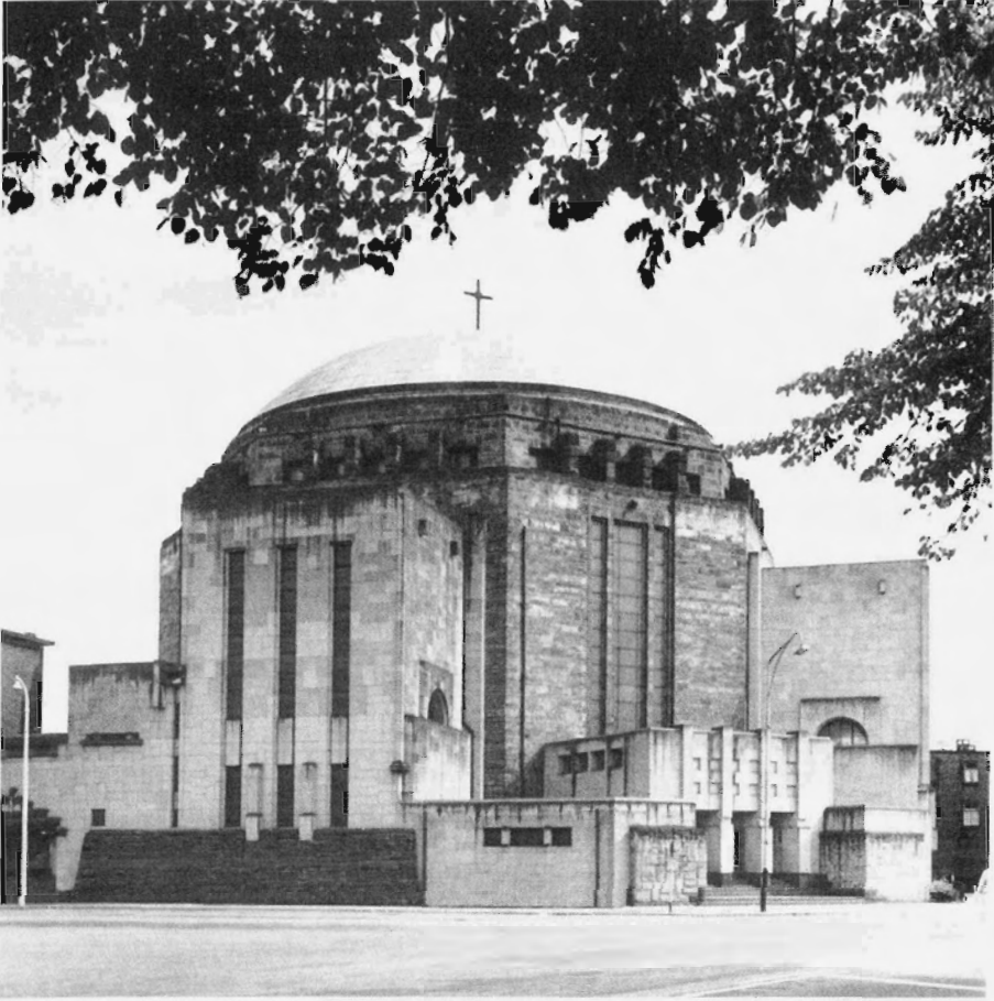
De Koepelkerk in Maastricht, vlak na het gereedkomen van de derde bouwfase: de hoofdingang en zijkapel in 1953. Uit: W.A.A. Mes, De Koepelkerk (Maastricht 1997).
