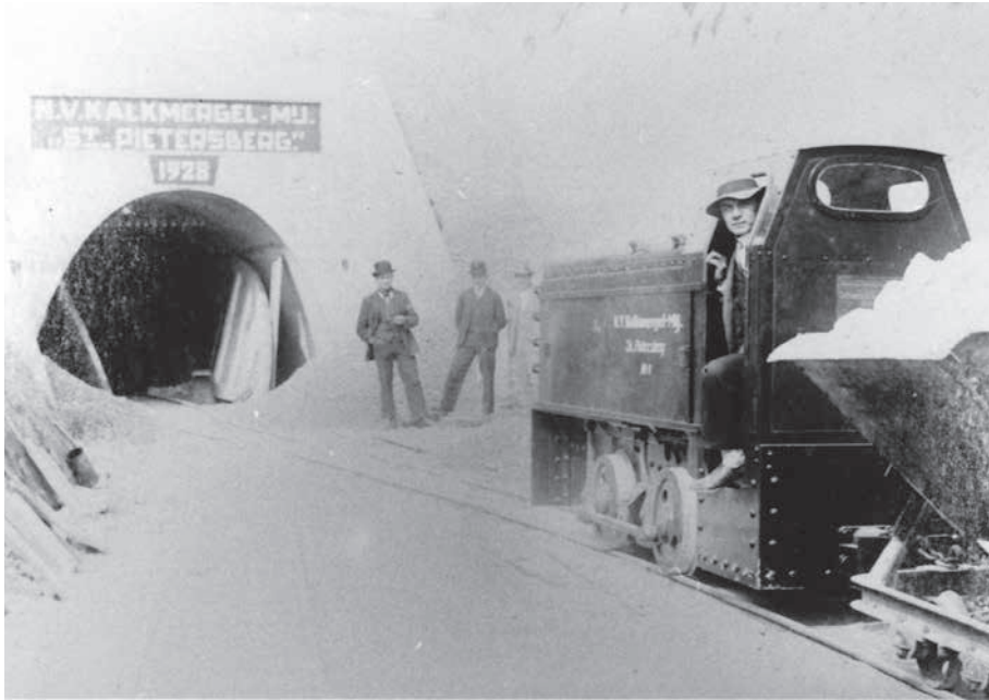
Ingang van de tunnel, de aanleg van de tunnel is hier al behoorlijk gevorderd. Er is al een spoor te zien, met een dieseltreintje erop dat wagonnetjes met mergel vervoert. Collectie Jan Spee.
