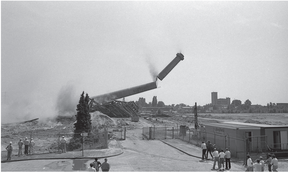
Met de val van de schoorsteen van de elektrische centrale, was nagenoeg al het erfgoed dat van de kernactiviteiten van de mijnindustrie getuigde, verdwenen. RHCL, fotocollectie Staatsmijnen/DSM.
